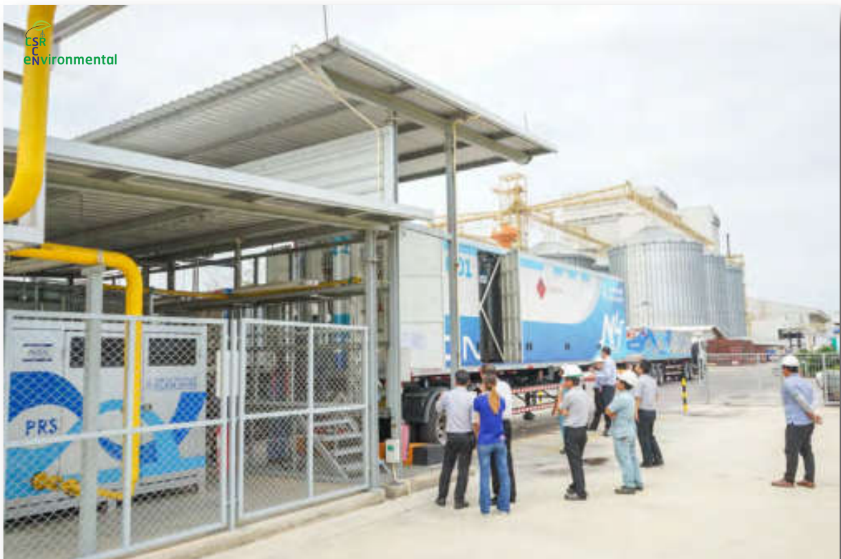
การขนส่ง และจำหน่ายก๊าซธรรมชาติอัด (Compressed Natural Gas, CNG) ให้กับโรงงานอุตสาหกรรม
